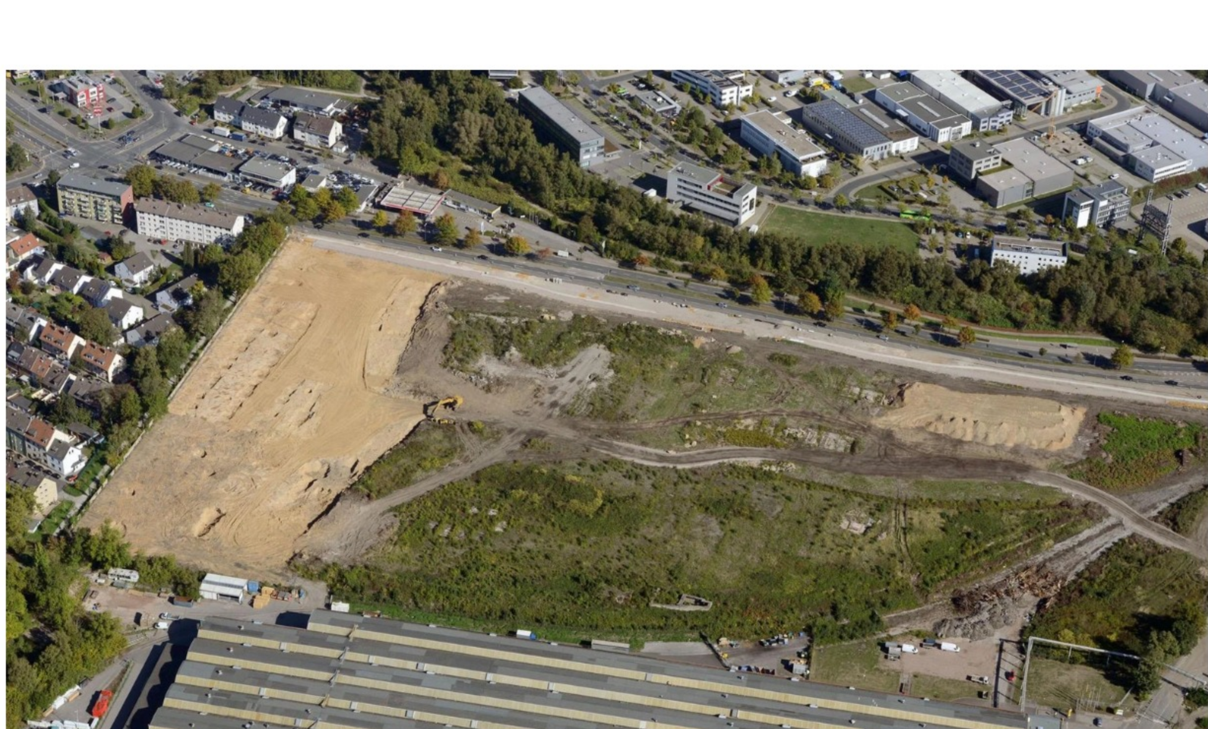
Auf einem Industriegelände an der Bottroper Straße in Essen kommen nicht nur Spuren des ehemaligen Walzwerks II zum Vorschein, sondern auch prähistorischen Gruben. © Baoquan Song | BAOQUAN SONG
